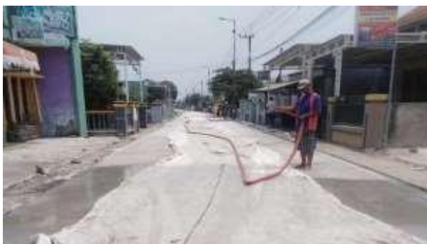
Gambar 4. Penutupan dan Peyiraman Beton
